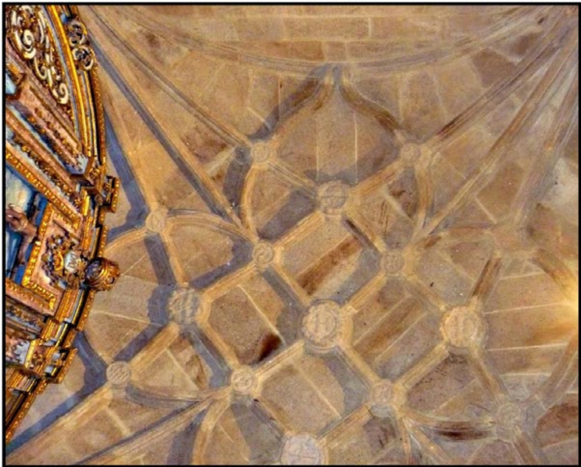
Vista xeral da bóveda.
