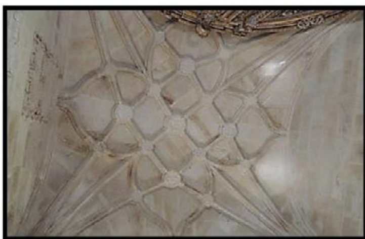
10. A bóveda estrelada da cabeceira da igrexa de Santa María de Guimarei.
