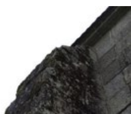
9. Parte alta contraforte
