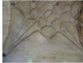
31. Arranque nervos bóveda de crucería.
