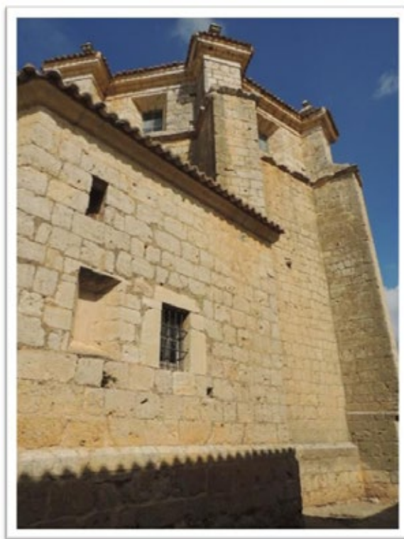
Muros de contrafortes de Santa María do Azogue en Uruña (Valladolid).
