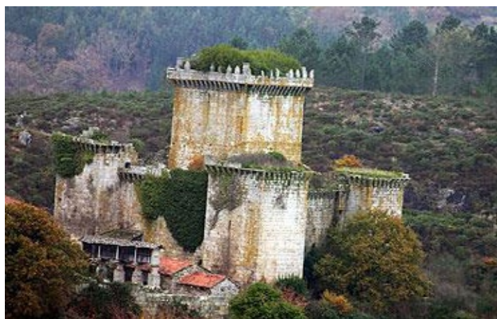
Sistema de modillón de rolos aplicado no castelo de Pambre.
