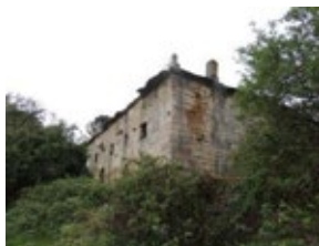
1. Vista xeral fachada.
