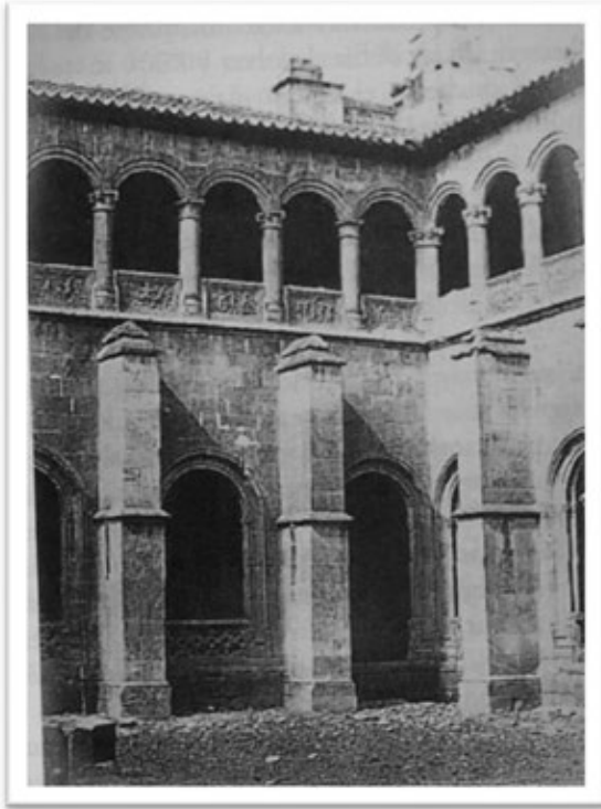
¿Claustro do Mosteiro da Vitoria?. Clifford (1853-1854). Contrafortes similares a Guimarei.
