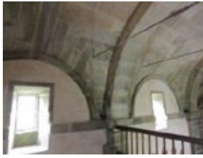
21. Parte alta nave con tirantes.
