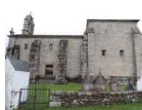
16. Lateral destacando contrafortes
